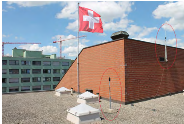
Bild: Messstation Muesmatt mit Lärmmessmikrofon und Radarempfangsanlage
